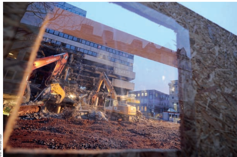
Der Abriss des Frappant auf der Baustelle Ikea in Altona hat begonnen: Rund 9000 Beschäftigte sind in der Baubranche tätig
